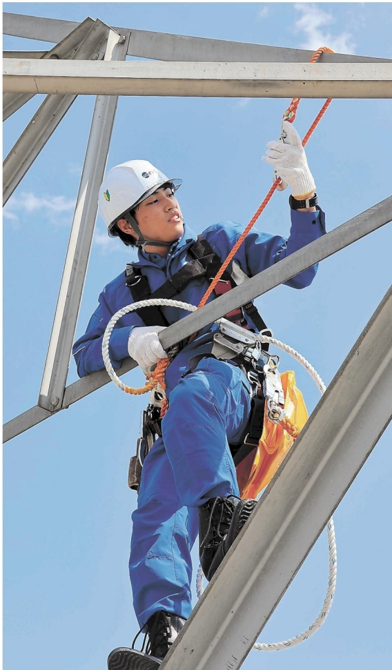
鉄塔に登って作業する研修生。足場が水平でないため、バランスを取るのが難しいという
