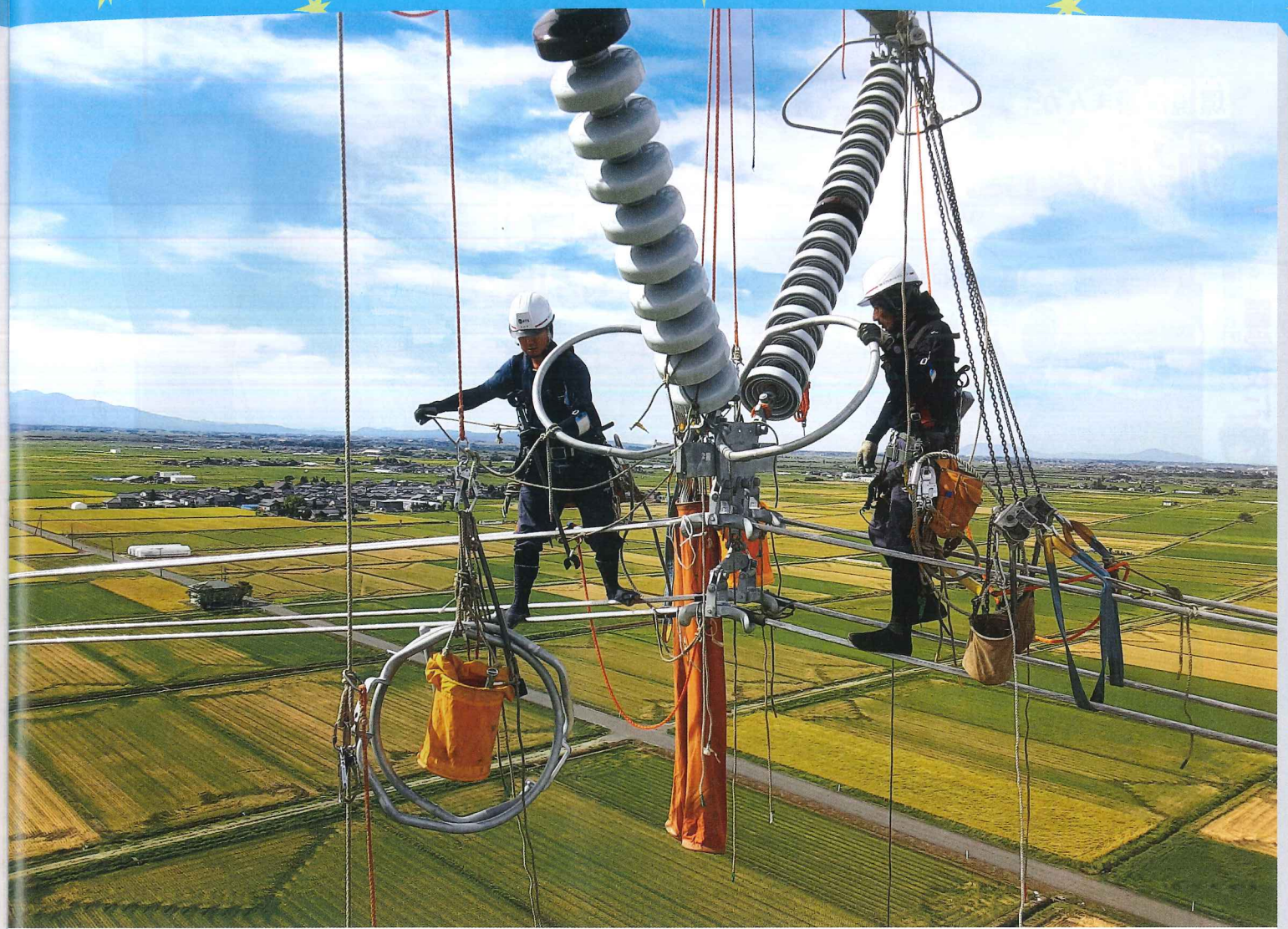
送電鉄塔の上で機材の荷揚げをしている様子(左が武田さん)
