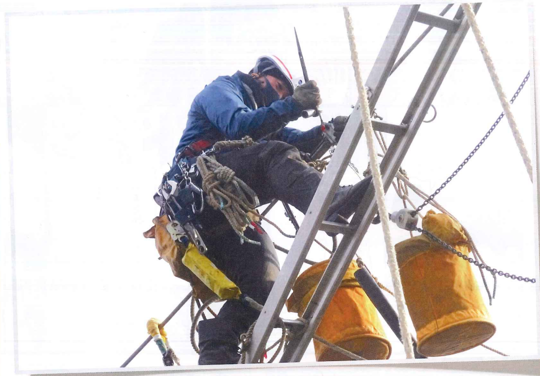
電線のたるみを規定値に調整する作業を終え、工具を取り外す武田さん
