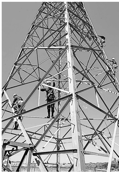
高さ約30桁の鉄塔を使った 研修に挑む新入社員ら
