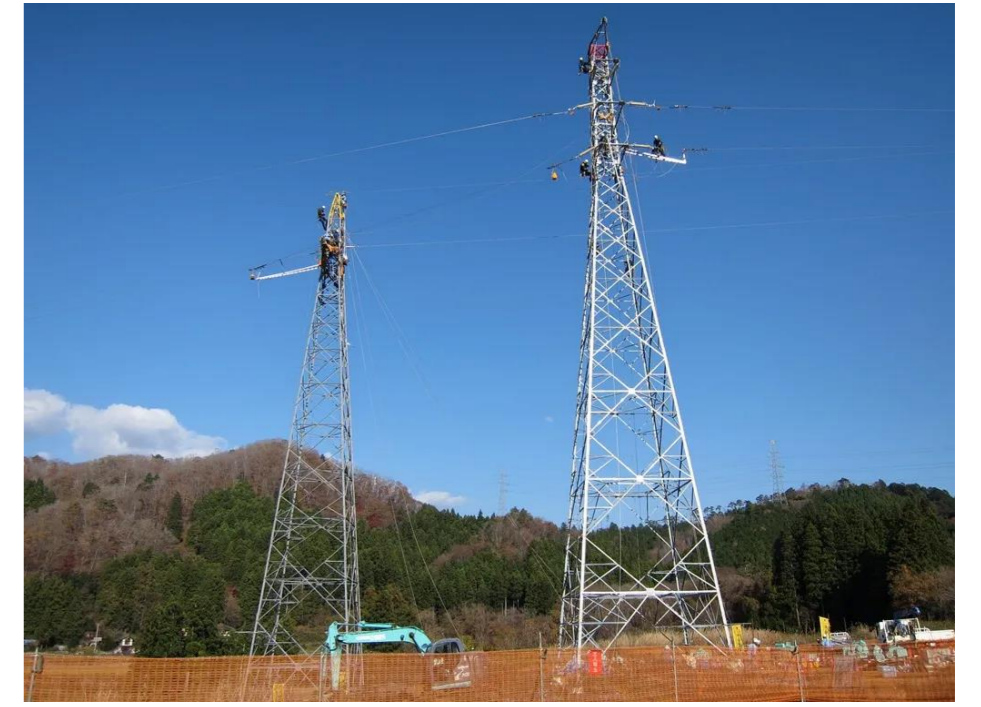
電力会社への連携線工事
