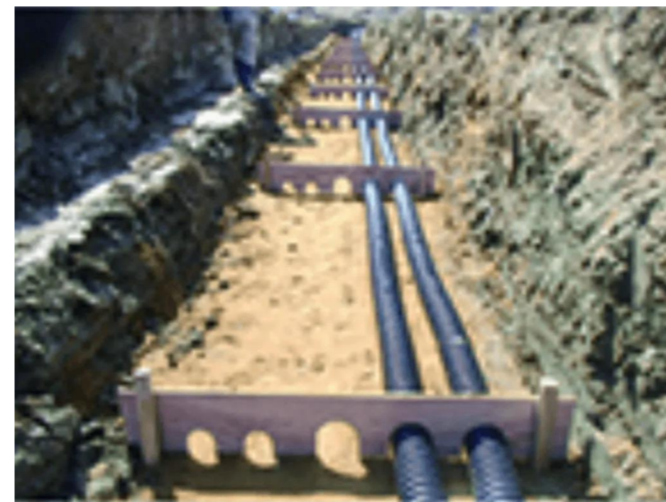
自営送電線路工事
