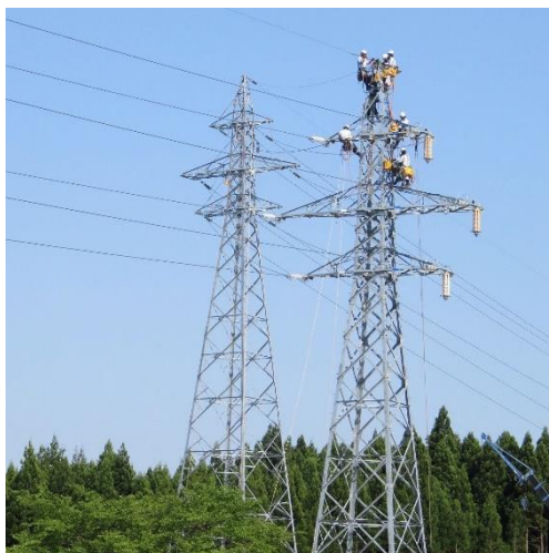
[当社ラインマンの作業の様子]
