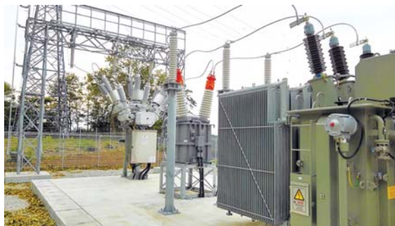
茨城県内で手掛けた特高変電所工事
