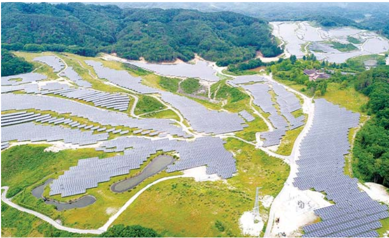
施工した30メガワットの福島県内の太陽光発電所
