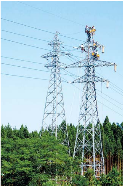
東北地方での鉄塔架線作業のようす
