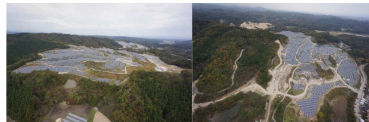
福島県白河市 (30.0Mw)
