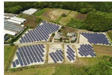
千葉県袖ヶ浦市(1.3Mw)
