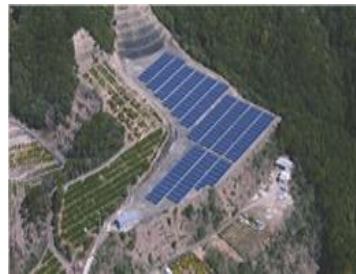
三重県御浜町(1.0Mw)
