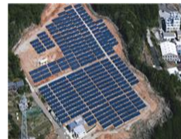
和歌山県新宮市(1.5Mw)
